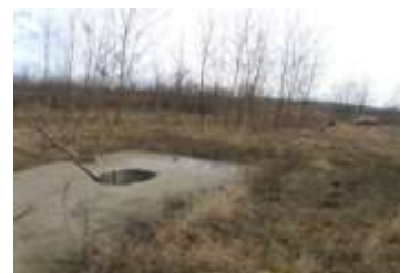
Sz-1 kút korábbi helyén előkészített hasonló fúrési betonlap
